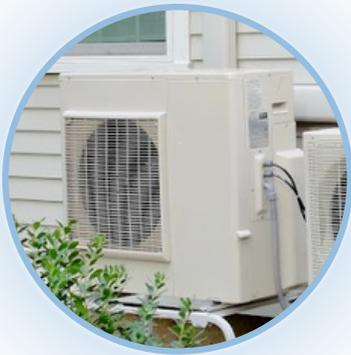
Los ASHP tienen un compresor exterior que siempre debe estar elevado por encima del suelo para mantener el ventilador interno por encima de la nieve.
